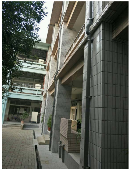
4. 南棟前側擴柱補強後外觀
