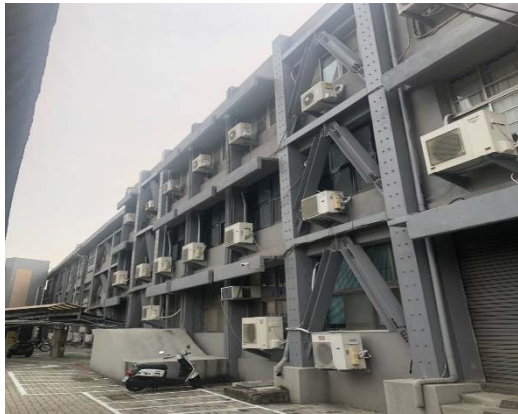
3. 南棟後側鋼斜撐補強後外觀
