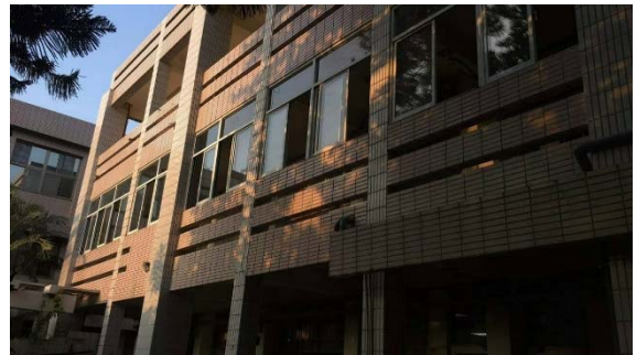
4. 南棟前側擴柱補強後外觀
