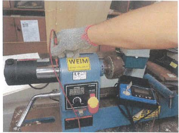
絕緣電阻值量測。
