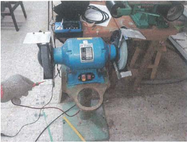
絕緣電阻值量測。
