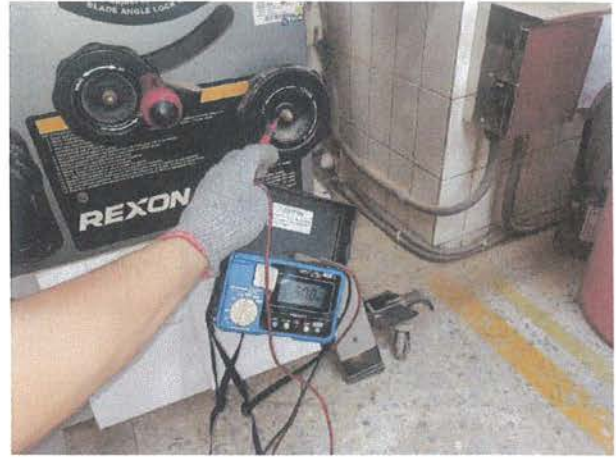
絕緣電阻值量測。
