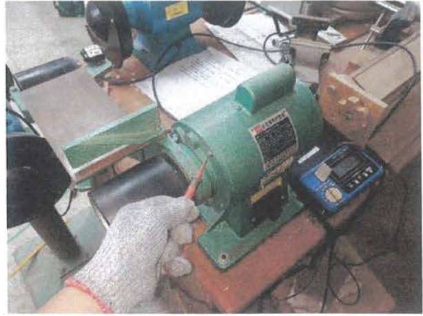
絕緣電阻值量測。
