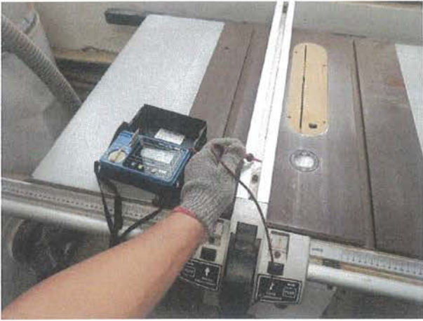
絕緣電阻值量測。
