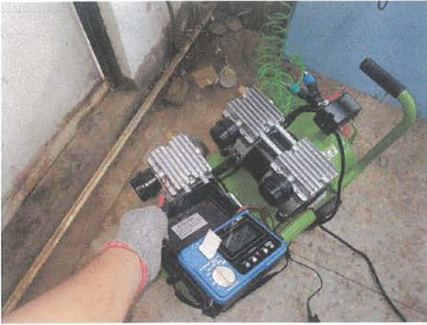
絕緣電阻量測。
