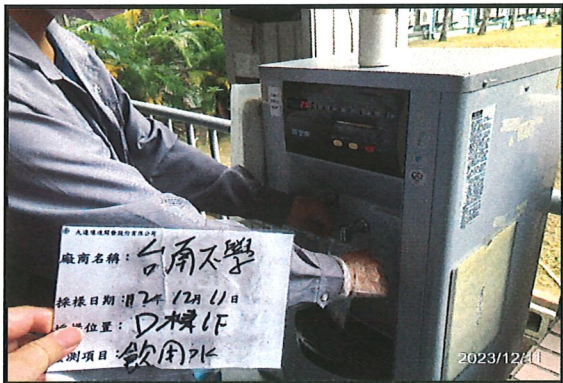
日期： 112.12.11 地點： 榮譽D棟1F 內容： 監測情形
