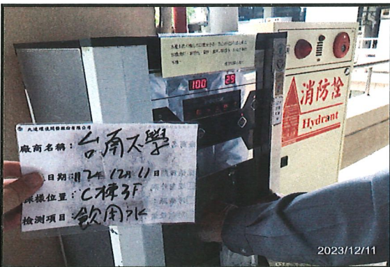
日期： 112.12.11 地點： 榮譽C棟3F 內容： 監測情形
