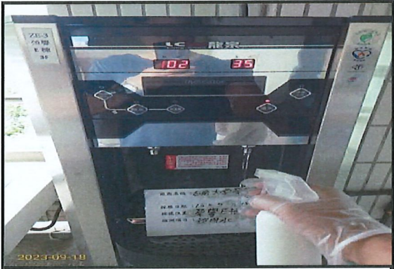
日期：112.09.18 地點：榮譽E棟 3F 內容：監測情形
