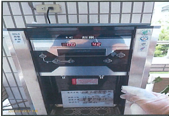
日期：112.09.18 地點：榮譽D棟 2F 內容：監測情形
