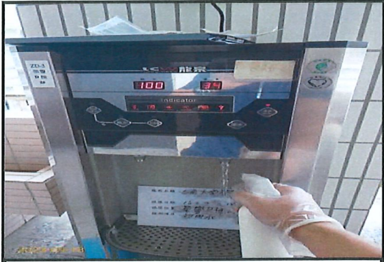
日期：112.09.18 地點：榮譽D棟 3F 內容：監測情形
