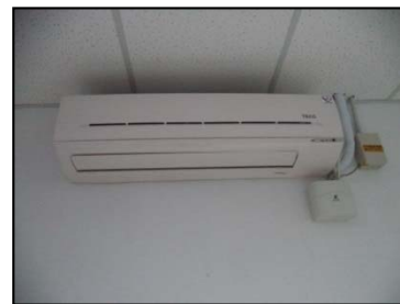
圖 5、汰換老舊高耗能窗型冷氣為分離式冷氣，並導入能資源智慧管理系統，搭配課表控制、卸載管控及停機排程功能
