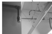
氣體式自動消防安全系統設備
