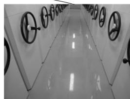
環氧樹脂(EPOXY)地坪
