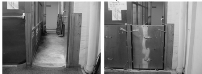
防水閘門(左圖：裝設前；右圖：裝設後)
