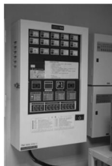
氣體式自動消防安全系統設備
